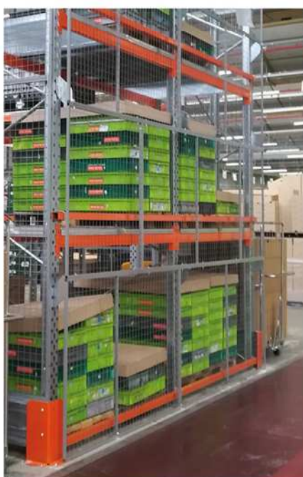
Rayonnage à palettes équipé de grilles anti-chute.
