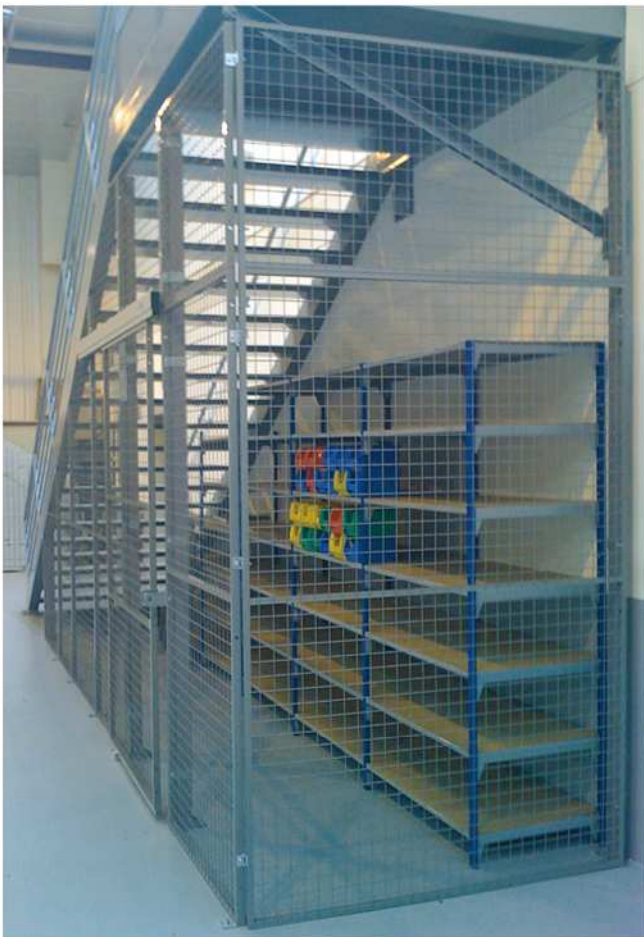
Protection d'un stockage sous escalier de plateforme.
