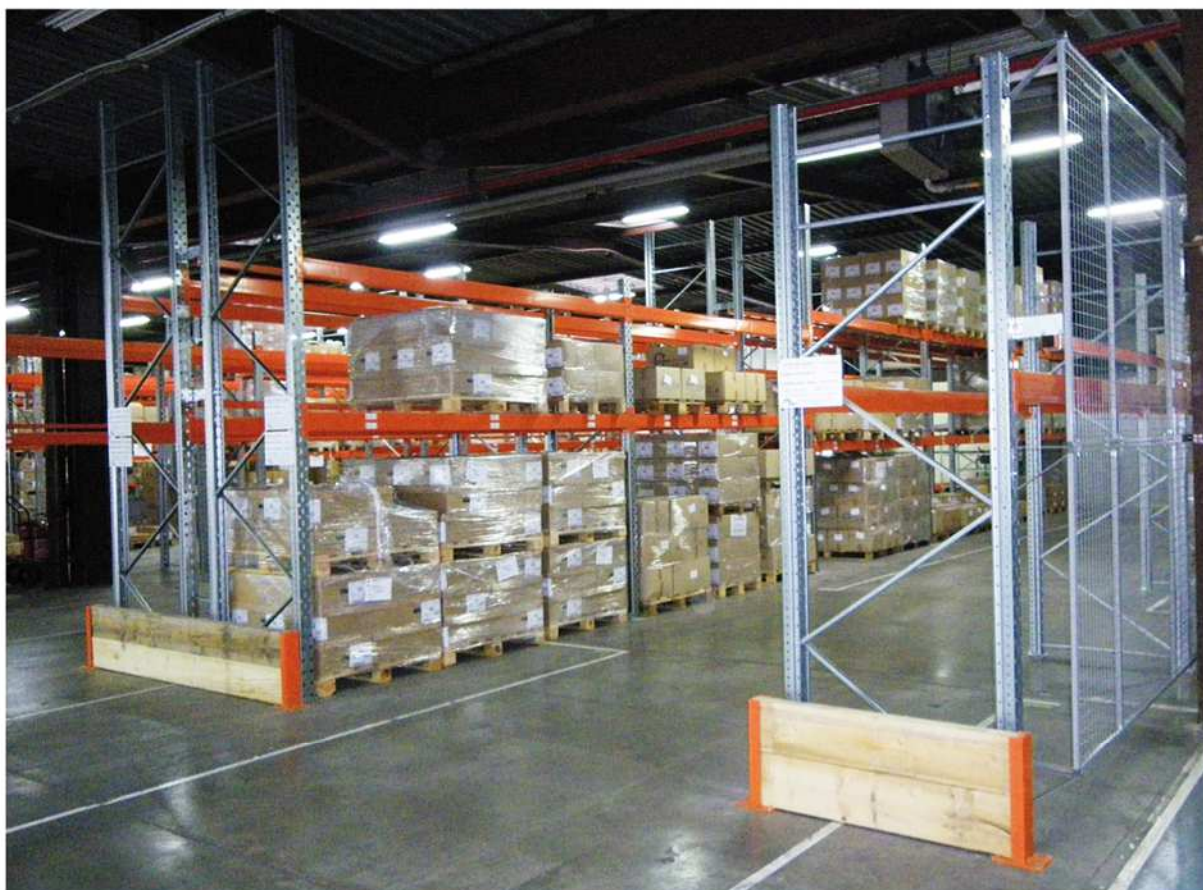
Rayonnage équipé de protections bout de rangée avec bastaing.
