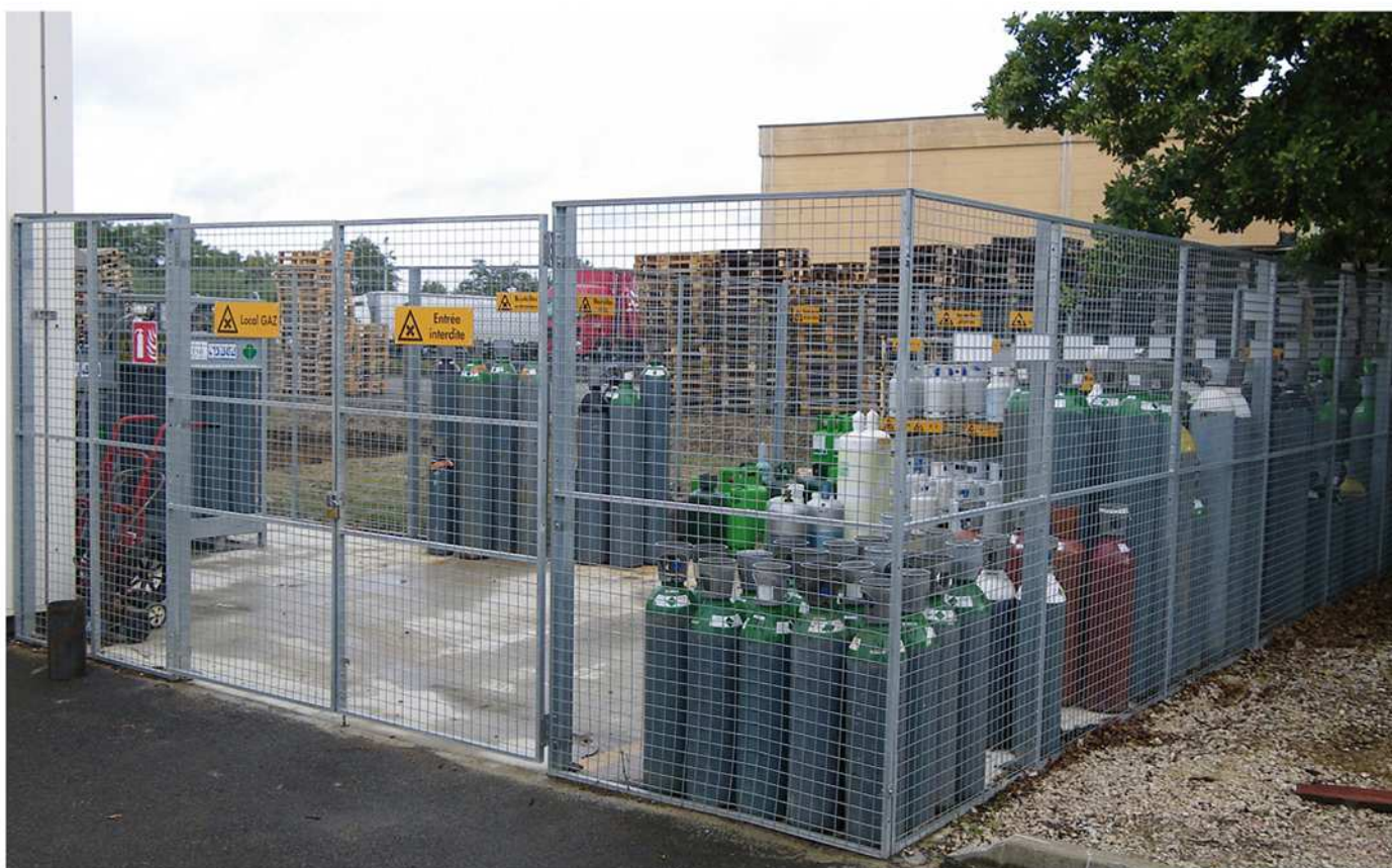
Mise en sécurité en extérieur de bouteilles de gaz.
