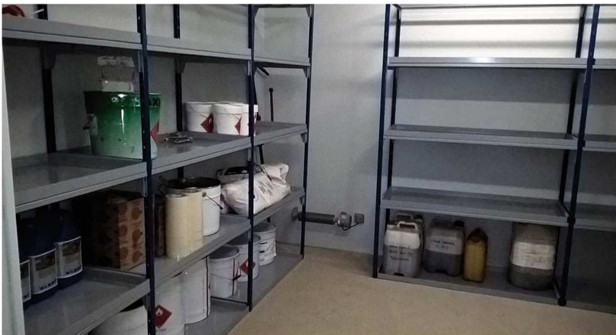
Rayonnage avec bac de rétention posé sur étagère.
