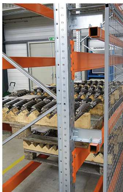
Rayonnage à palettes équipé de butées de palettes et grille anti-chute.
